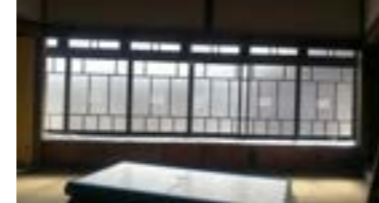
一部残存した2階建具を修理・復原
