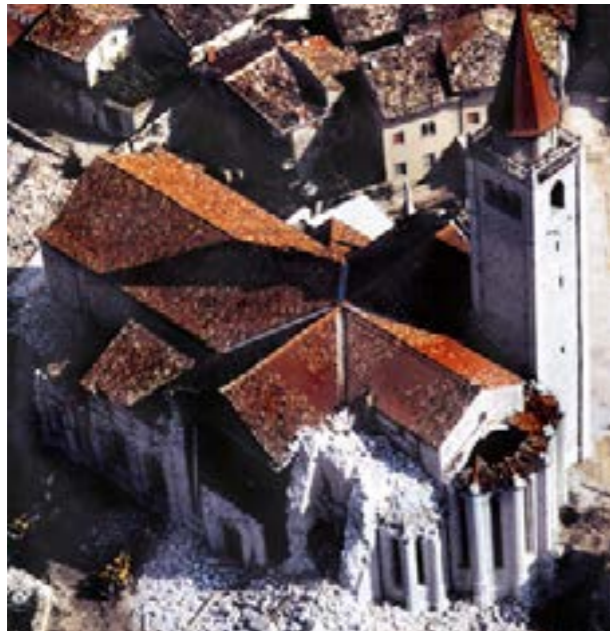
一撃目の被害状況
