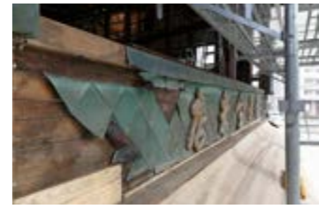
大ばらしした正面看板部分を復原、銅板葺きを継ぎ補修
