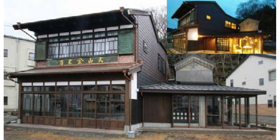
修理工事完了後の外観写真
