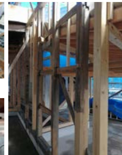
柱材の根継(継手を千鳥に配置する)
