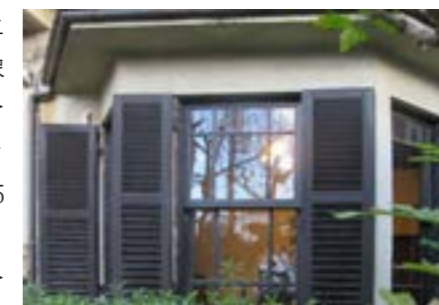
上げ下げ窓外観
