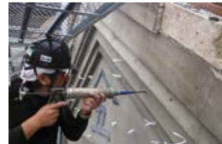
蔵妻壁の保存補強(ピンディング)
