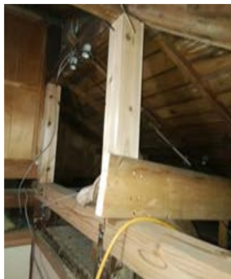
小屋裏の工事完了後
