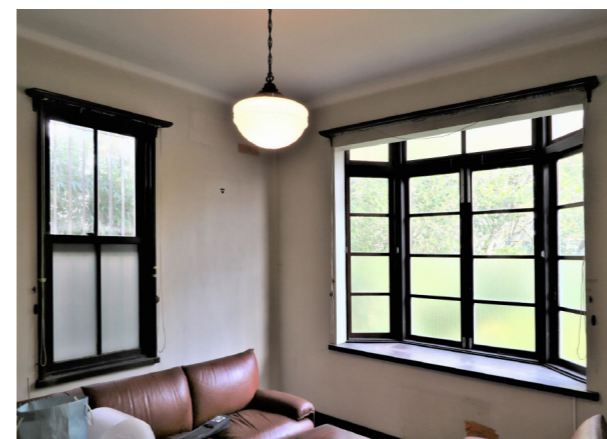
洋館（応接間）出窓と上げ下げ窓
