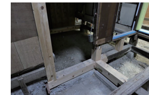
切断されていた土台と柱の復旧
