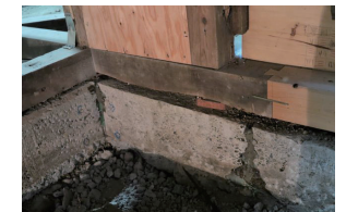
基礎補修と土台継木
