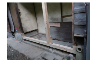
腐朽土台と柱の入れ替え
