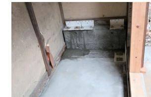
高基礎の補強と土台固定
