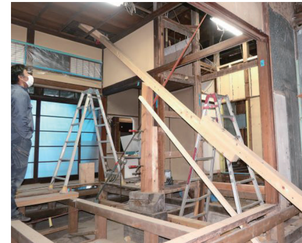
既存柱の建て直しと沈下補正工事
