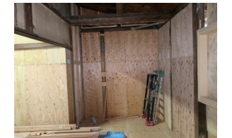
耐力壁取付後の床張
