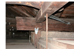
小屋組の補強金物取付
