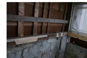
土台の埋木と土台新設
