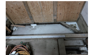
新設基礎と土台固定金物
