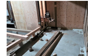
耐力壁と増設した基礎と土台固定
