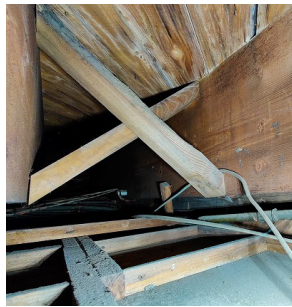
天井裏に施されていた補強
