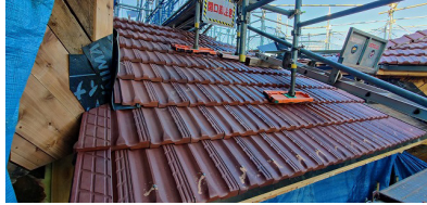
使用人室棟の新規製作 復原フランス瓦
