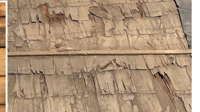
瓦下地トントン葺き (薄剥ぎ板葺き)
