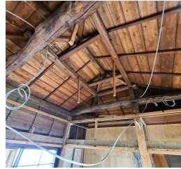
使用人室小屋裏
