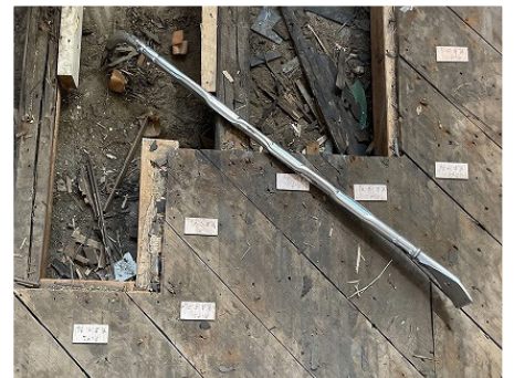
床板に番号札を付けて解体
