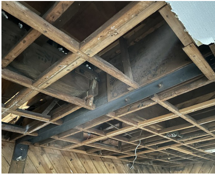
当初から施されていた鉄骨補強
