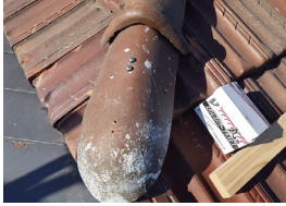
既存かっぽん復旧
