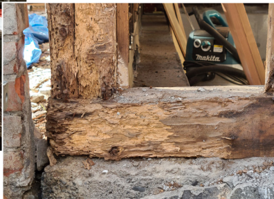
土台・柱脚腐朽
