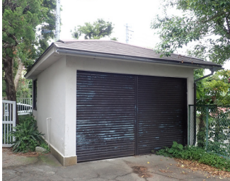
解体前の車庫
