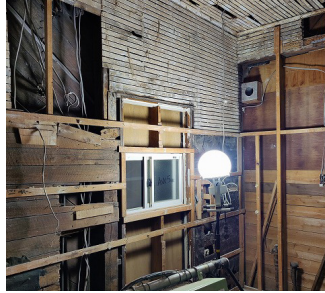
キッチン 木摺下地壁・勝手口痕跡
