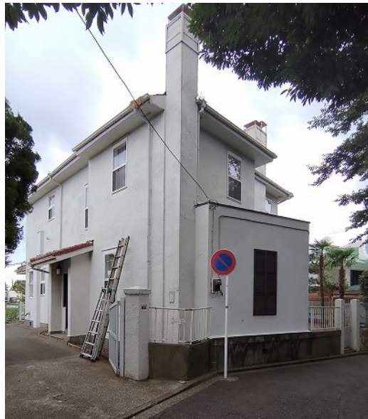
修理前西外観
