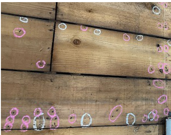
釘穴調査 (白丸と赤丸で施工時期が異なる)
