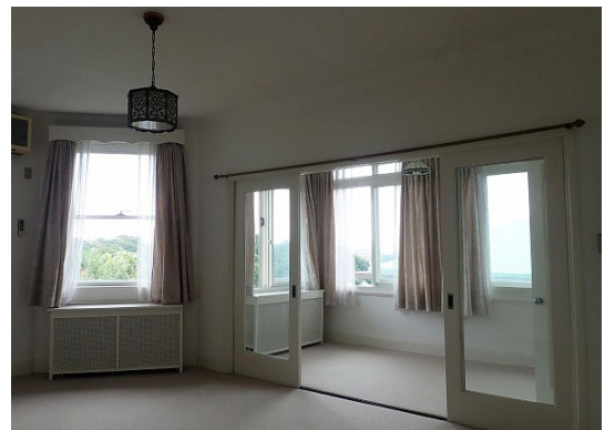
修理前寝室1・サンルーム
