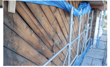
主屋外壁杉板斜め張り
