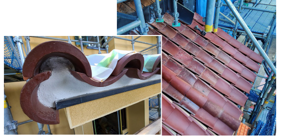
玄関ポーチのスパニッシュ瓦
