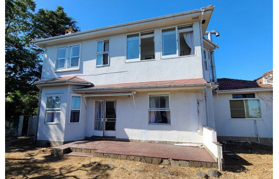
修理前南外観
