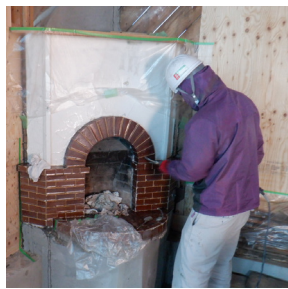
応接間 暖炉塗装はがし
