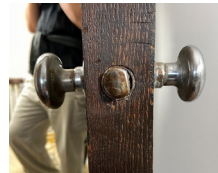
ドアノブ修理
