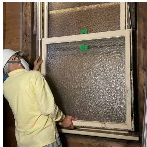
作業室 オリジナル上下窓
