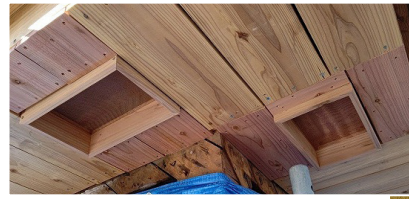
軒天換気口復原
