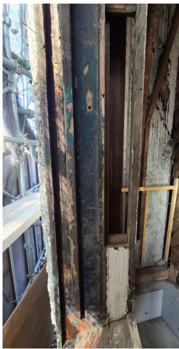
作業室 上下窓枠 (当初)
