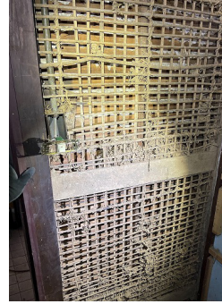
木摺下地 痕跡
