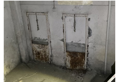
ボイラー室の石炭投入口
