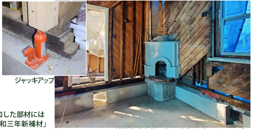
補強基礎を施工後、建物をジャッキアップし 土台の腐朽土台を交換する
