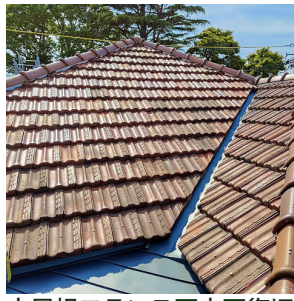
大屋根フランス瓦古瓦復旧
