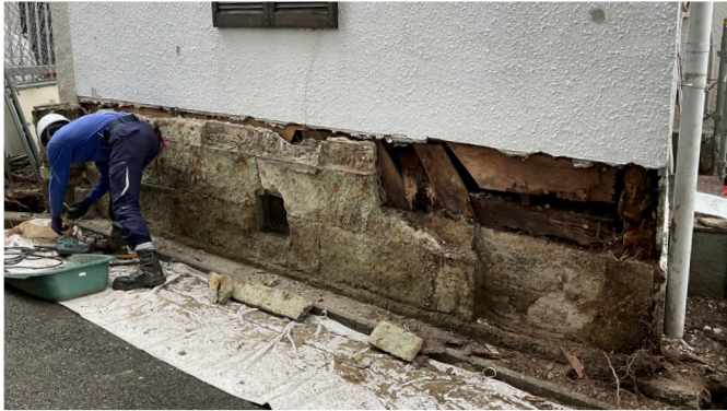
作業室基礎解体
