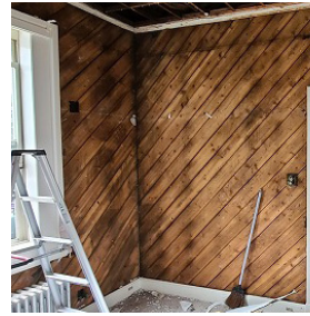
壁下地杉板斜め張り
