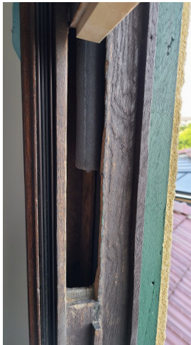
上下窓 分銅点検口
