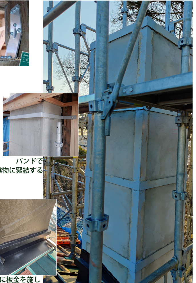
鉄骨による煙突の補強
