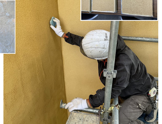
外壁仕上リシン掻き落とし
