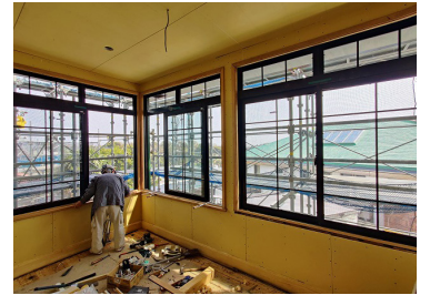
アルミサッシによる 木製建具デザインの復原
