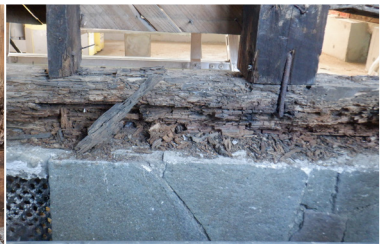
土台・柱脚腐朽
