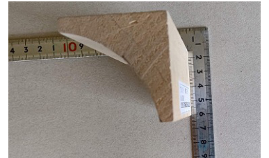
天井廻縁蛇腹材復原
