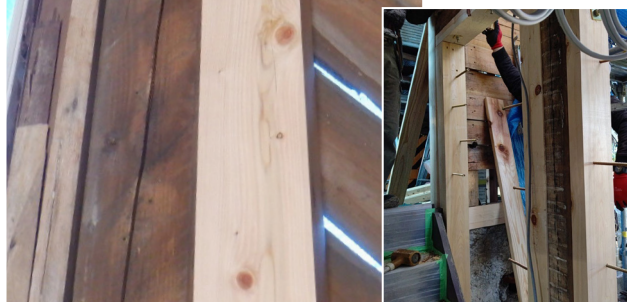
既存の柱に新規の柱を抱き合わせる
