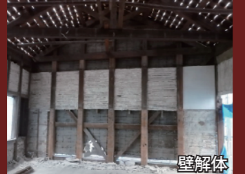
仕上が解体され構造軸組みが現れる
