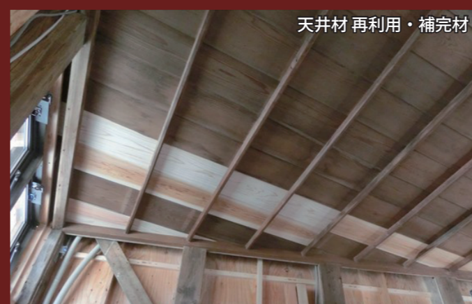
2階床板左補完材・右再利用材
