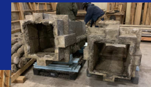
外壁柱飾の修繕
