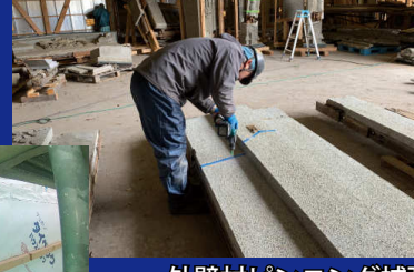
外壁材ピンニング補強
