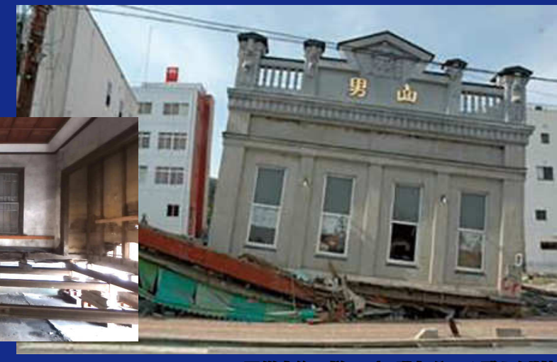
震災直後の様子(3階部分のみ残り倒壊)
