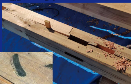
金輪継による継手
