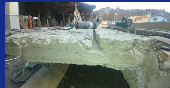
外壁材再取付の為の T 型溝加工
