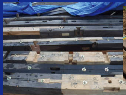
新補材には焼き印を施す→ 木材腐朽箇所の繕い
