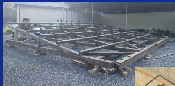
小屋組の仮組
