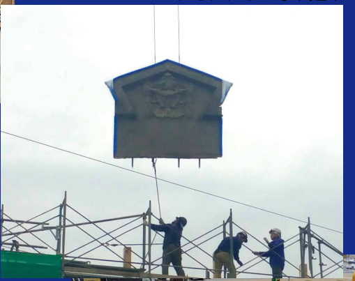
ペディメントの吊り込み
