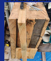
木材端部変形箇所のほぞ改修
