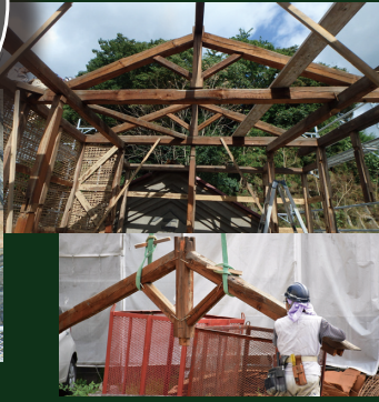
トラスの解体
