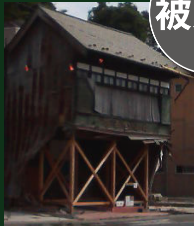
震災後に応急補強が行われた
