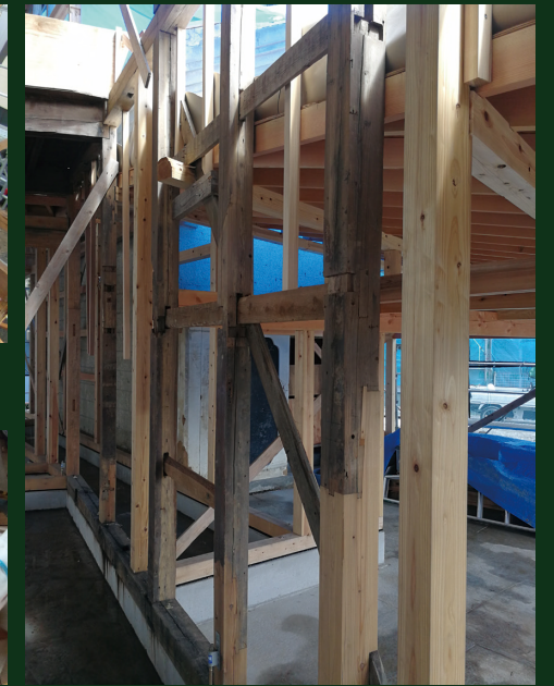
柱材の根継（継手を千鳥に配置する）
