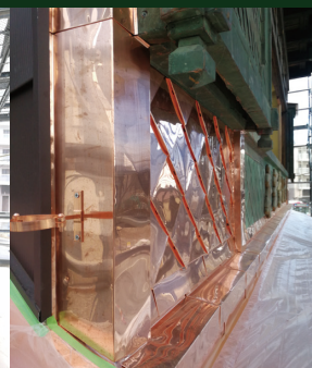
大ばらしした正面看板部分を復原、銅板葺きを繕い補修
