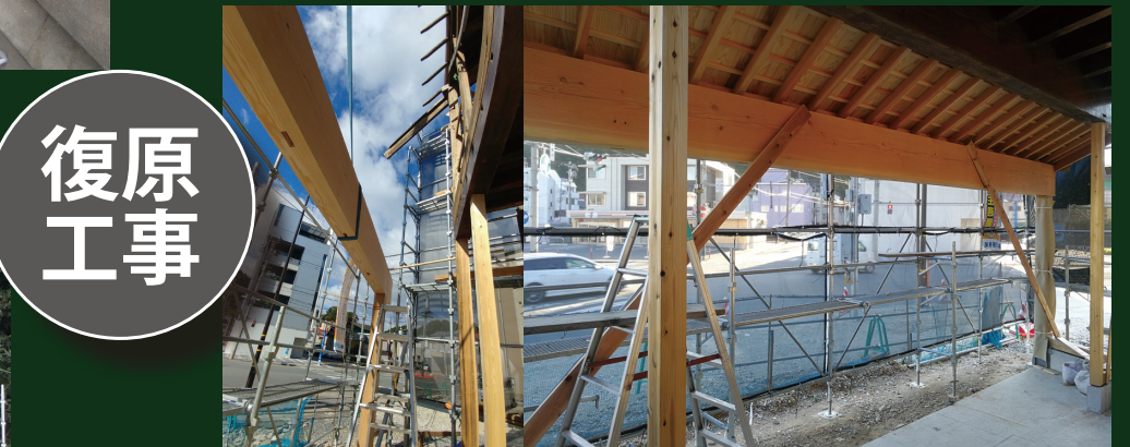
流失した下屋部分の復原（残存する部材に残る痕跡から形状を復原した）
