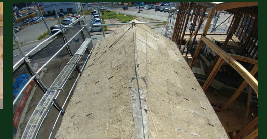
蔵の屋根を補修（塩釜石）
