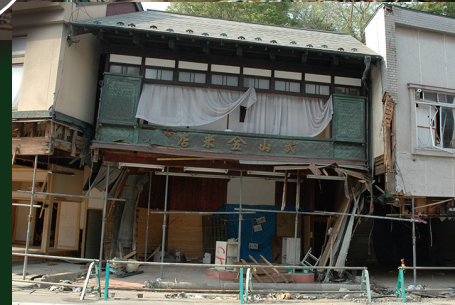
津波で1階店舗正面下屋部分が流失、内部にも大量の瓦礫が流入した
