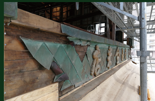
大ばらしした正面看板部分を復原、銅板葺きを繕い補修
