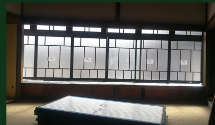
一部残存した2階建具を修理・復原
