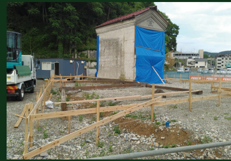
梁の地組による形出し
