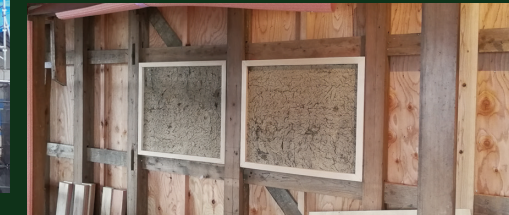
大ばらしした土壁を元の位置に設置
