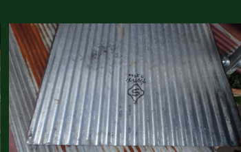
オリジナル外壁（亜鉛引鉄板）
