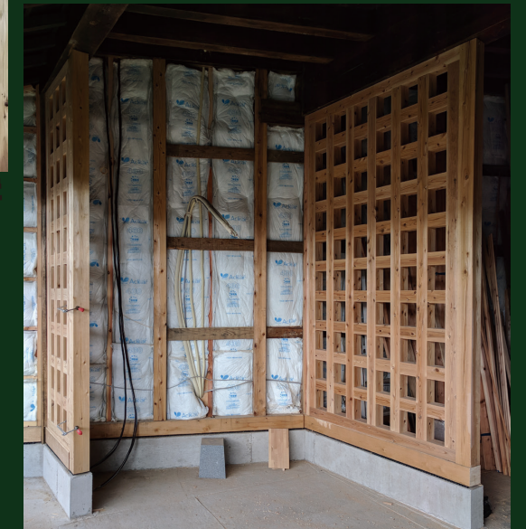
高耐力面格子耐力壁を新設（1階店舗部分）
