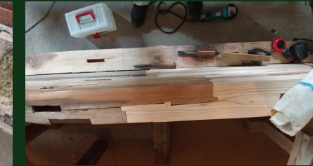
「金輪継」による柱材の繕い
